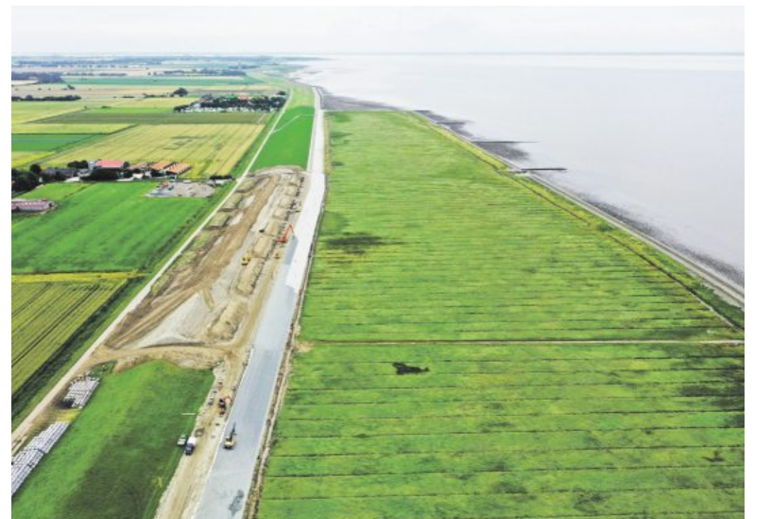
Deichbau heute: Wie hier in der Krummhörn in Ostfriesland werden die niedersächsischen Deiche bei Bedarf fortlaufend erhöht und verstärkt. Dabei setzt man heute auf ein im Vergleich zu 1962 optimiertes Deichprofil Foto: NLWKN.
