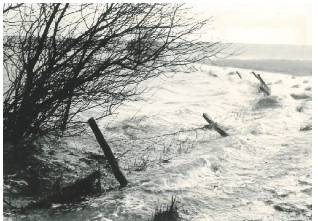
Auch in Müggendorf wurden die Flächen vom Wasser überspült
