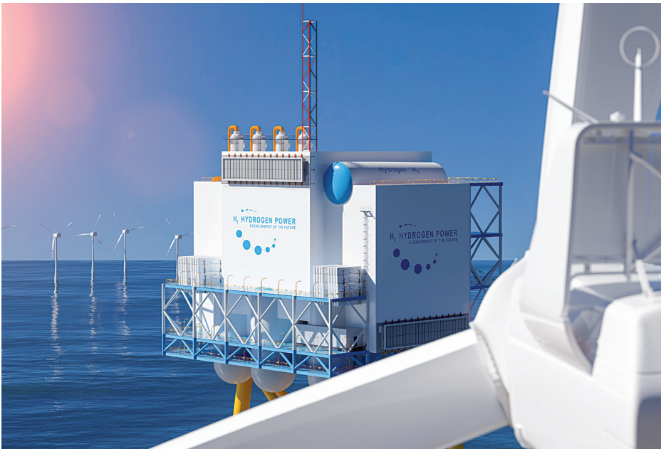
Animation einer Offshore Windkraftanlage vor Helgoland. Ihre Aufgabe: die dezentrale Herstellung von Wasserstoff mittels modularer Elektrolyseure. Foto: AdobeStock
