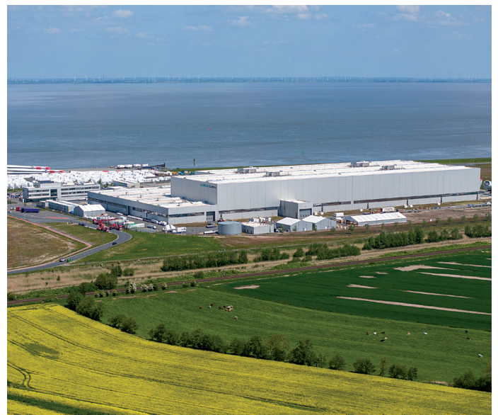
2023 Blick auf das Werk und den Hafenbereich
