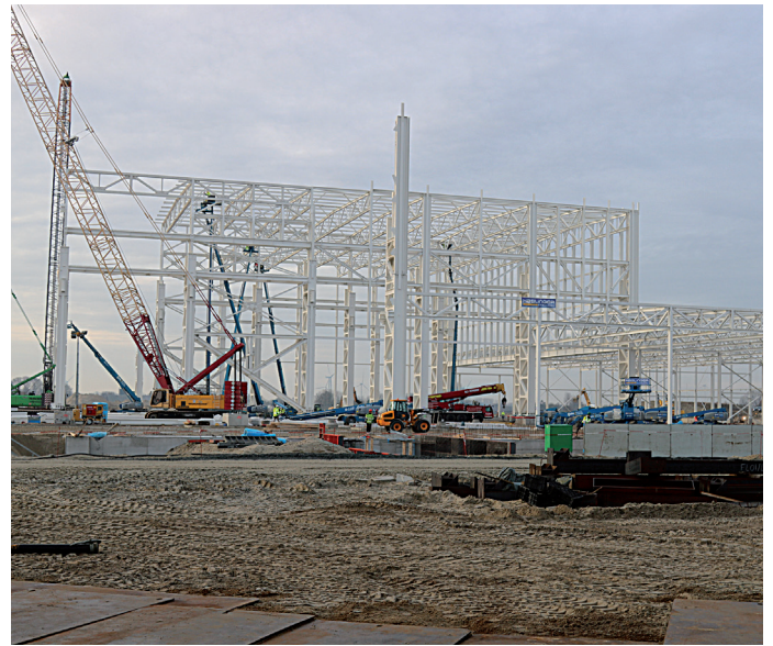
2017 Das Grundgerüst steht
