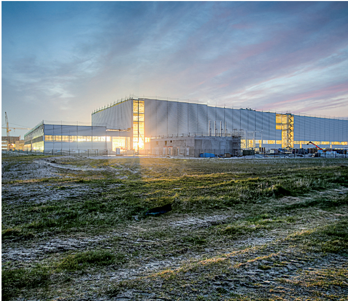
2018 Die Außenwände werden installiert
