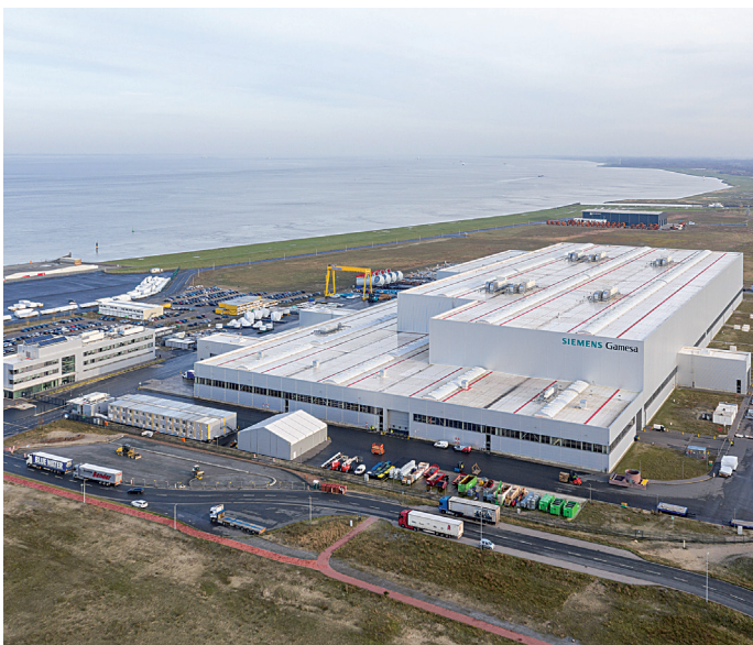
2020 Die Fertigungshalle und das Bürogebäude sind fertiggestellt
