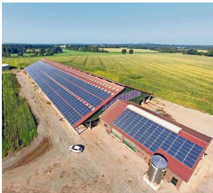
Großflächen werden von Sandmeyer gepachtet für den Aufbau- von Voltaikanlagen. Fotos: Sandmeyer
