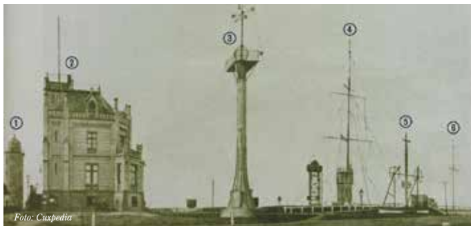
Cuxhavens Küstenlinie an der Alten Liebe zeigte 1914 etliche Signalanlagen, die die Seeleute mit wichtigen Informationen versorgte. ① Leuchtturm, ② Telegraphengebäude, ③ Zeitball, ④ Marinesignalstation, ⑤ Semaphor, ⑥ Sturmsignal. Fotos: cuxpedia
