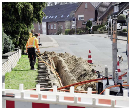
Es geht blitzschnell und fast komplett ohne jede Belästigung oder Beeinträchtigung: Das Verlegen der Leerrohre für die Glasfaserkabel. Foto: AdobeStock
