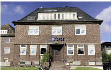
Das alte Lotsenhaus – Sitz der Cuxhavener Niederlassung. Foto: Ahrens
