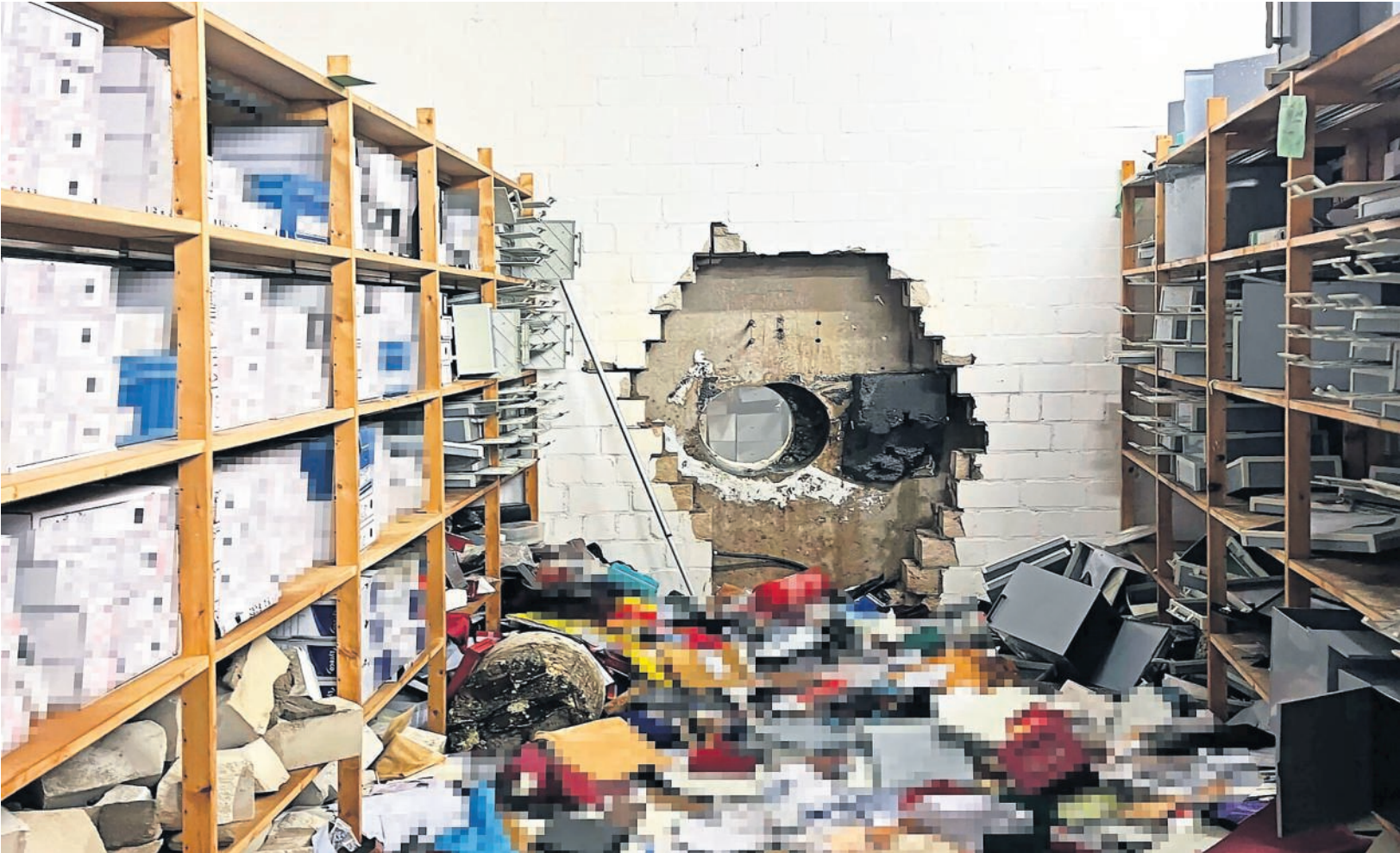
Großes Loch in der Wand zur Sparkasse in Gelsenkirchen: Am 29. Dezember verschafften sich Einbrecher mit Hilfe eines großen Bohrers Zugang zum Tresorraum. Dort brachen sie die Wertschließfächer auf. Foto: Polizei Gelsenkirchen/dpa
