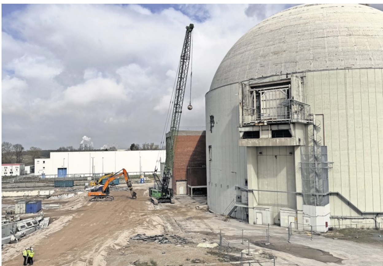
Das Kernkraftwerk Stade wird abgerissen. Es ist bereits seit Jahren abgeschaltet. Am Rückbau ist das Bülkauer Unternehmen Freemuth maßgeblich beteiligt. Foto: dpa / PreussenElektra GmbH
