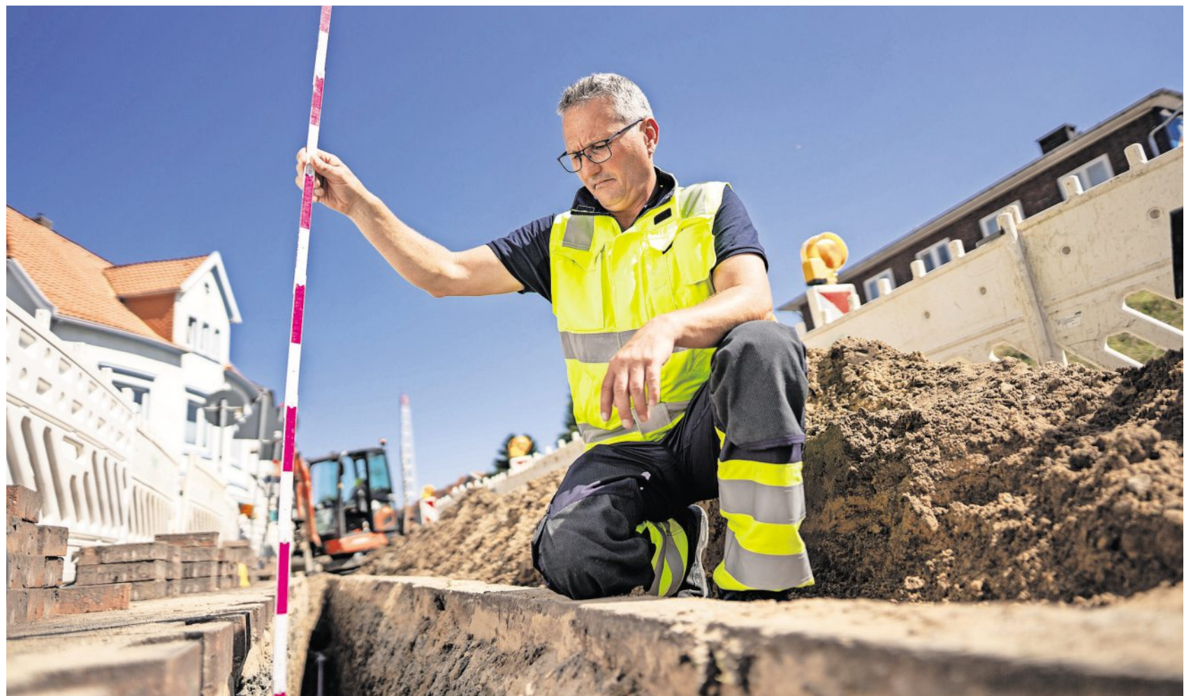
Viele Projekte beim Netzausbau werden gemeinsam mit Partnerbetrieben vor Ort umgesetzt. Foto: Philipp Eigner / EWE NETZ
