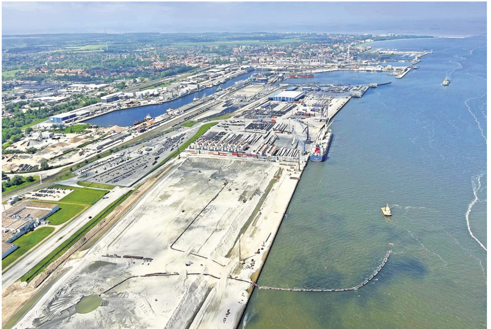
Aus der Luft wird deutlich, wie weit die Arbeiten bereits fortgeschritten sind. Luftfoto: Makel
