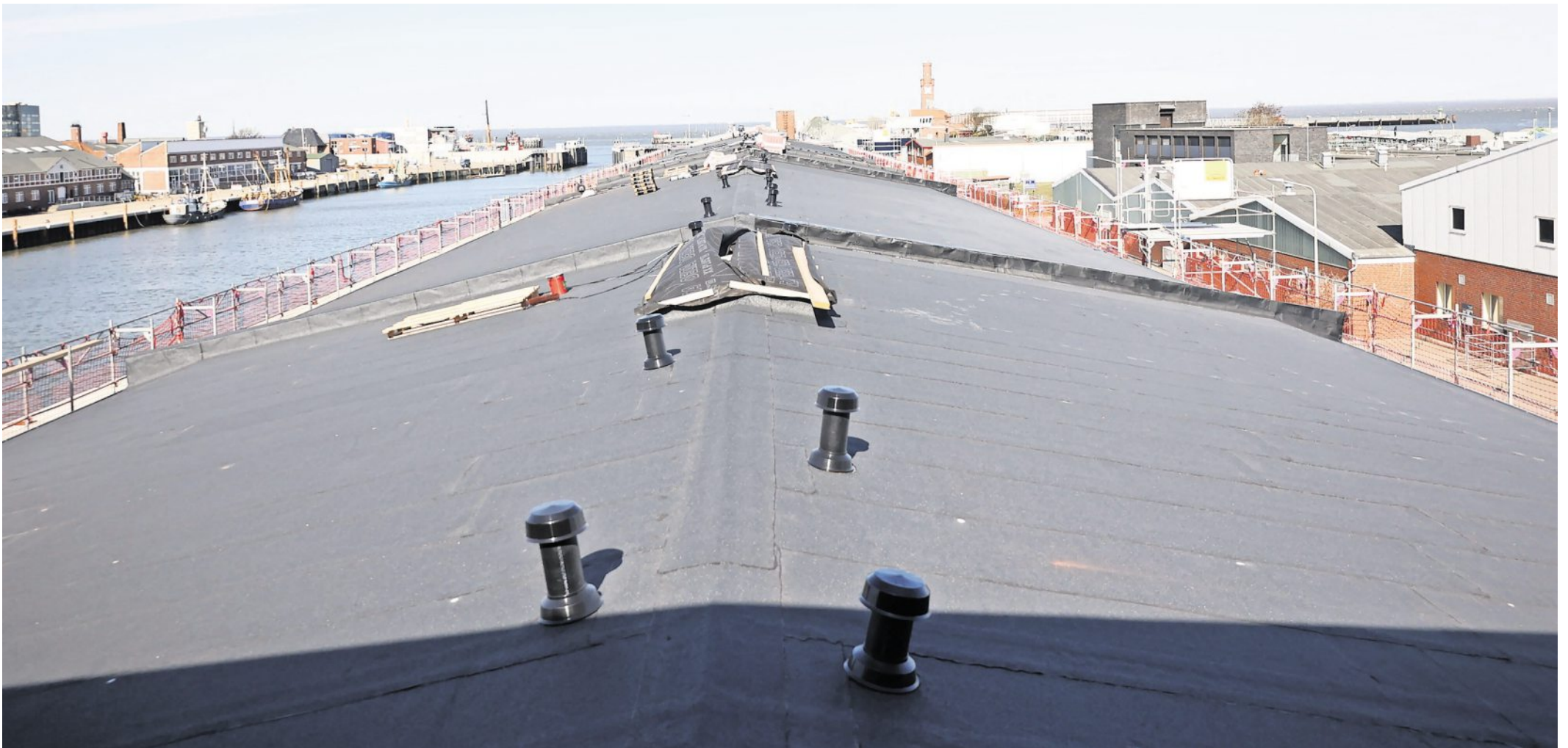
Auf das neue Dach der Fischhallen soll auch Photovoltaik installiert werden. Foto: Larschow
