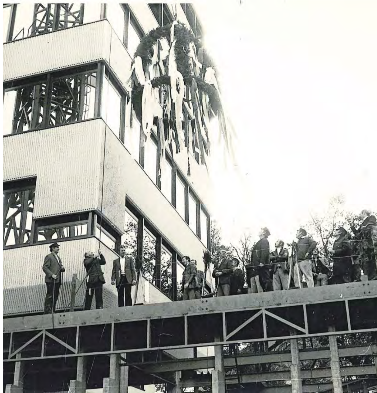
Richtfest für den Neubau der Stadtsparkasse Cuxhaven.
