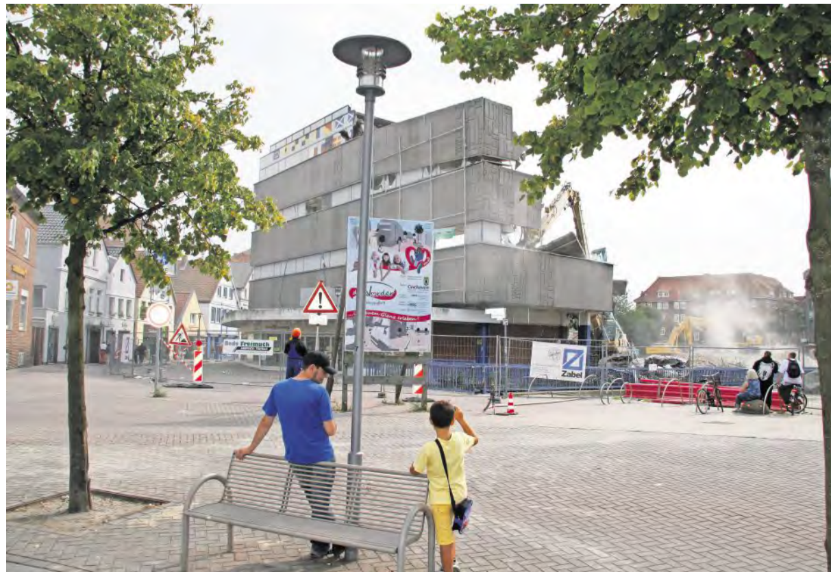
Der Abriss des Karstadt- bzw. Hertie-Gebäudes war für viele Tage ein Besuchermagnet. Foto: Potschka
