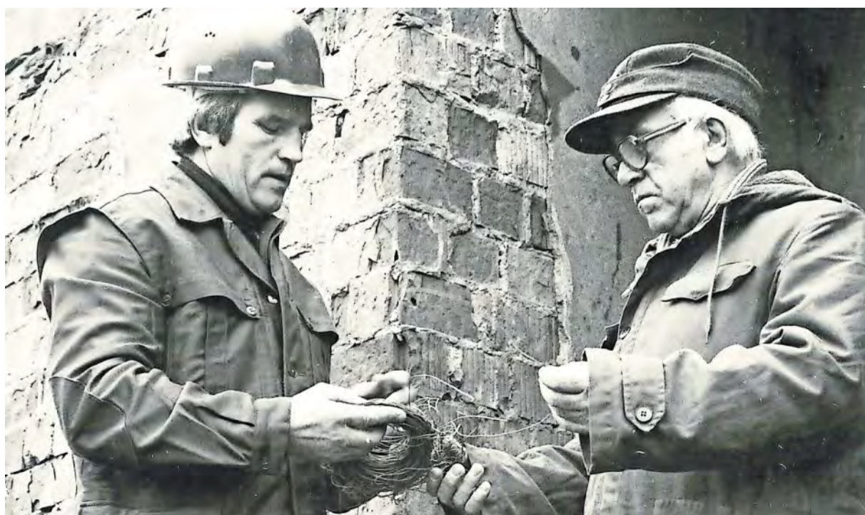
Experten bereiteten die Sprengung des Bunkers hinter der Grimmershörnbucht in Döse vor.
