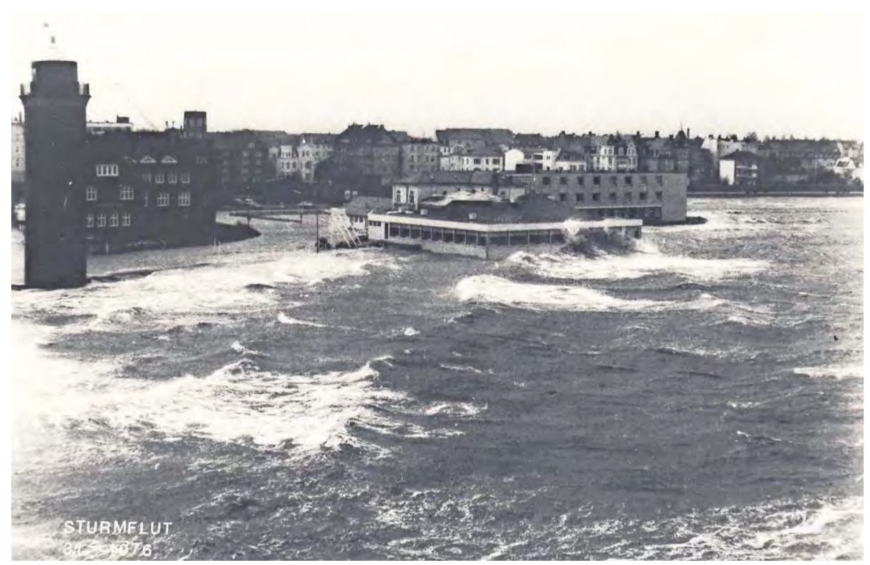
Der Sturm brandete auch gegen den Seepavillon. Wenige Schritte entfernt wurde ein tonnenschwerer Ponton aufs Land geworfen.
