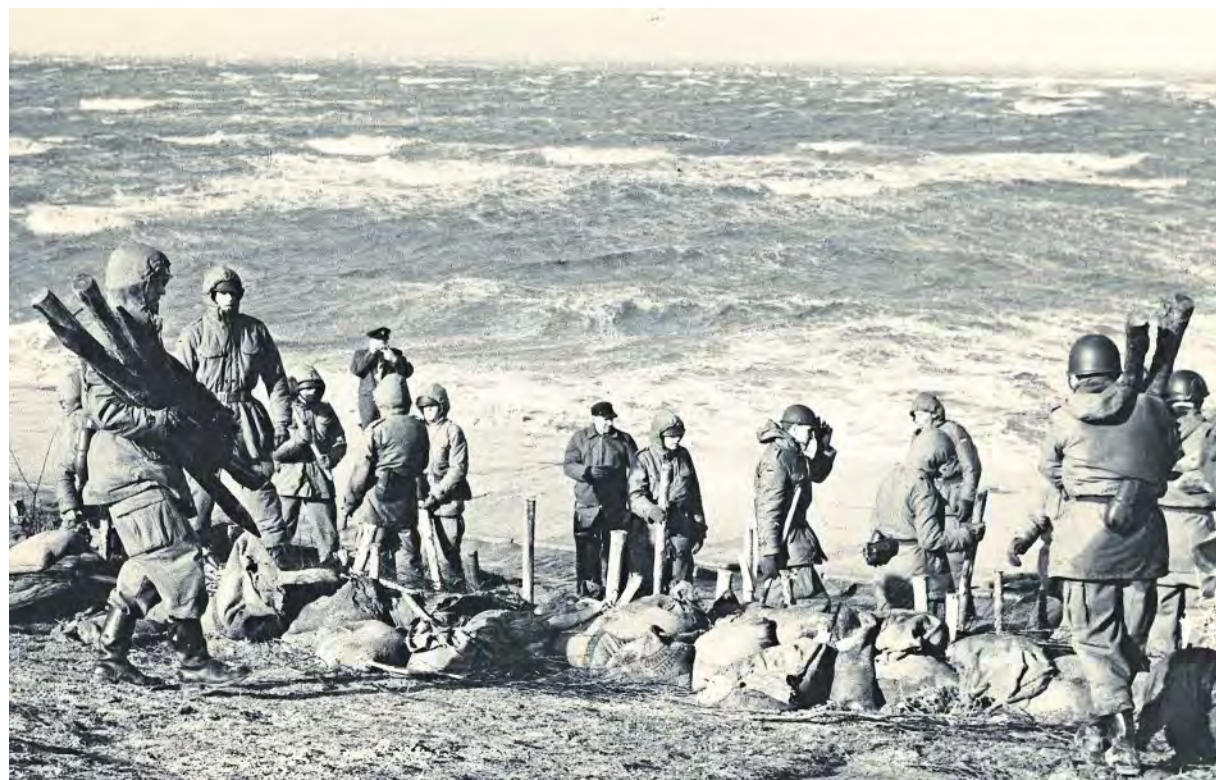
Die per Rundfunk und Fernsehen aus dem Urlaub nach Cuxhaven zurückgerufenen Soldaten sicherten die Sandsäcke mit Pfählen vor dem Davonschwimmen.
