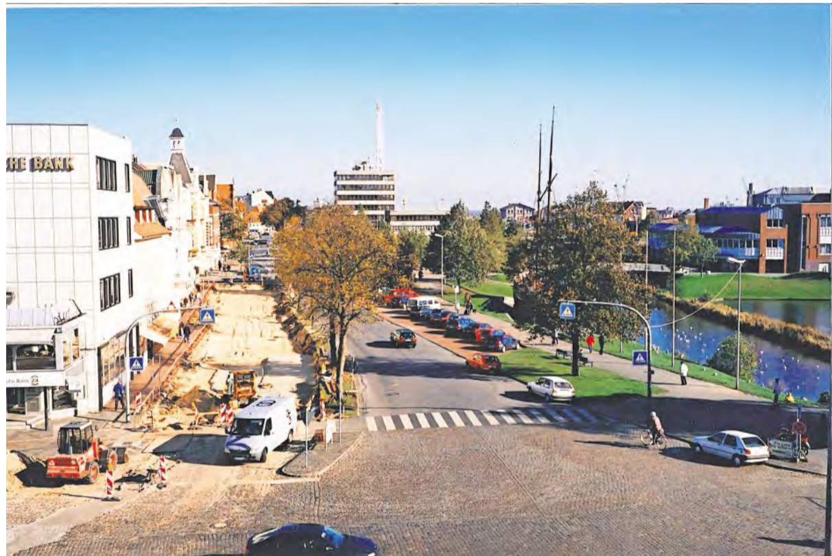
Bauarbeiten in der Deichstraße im Zuge der Umgestaltung zum „Butt“.
