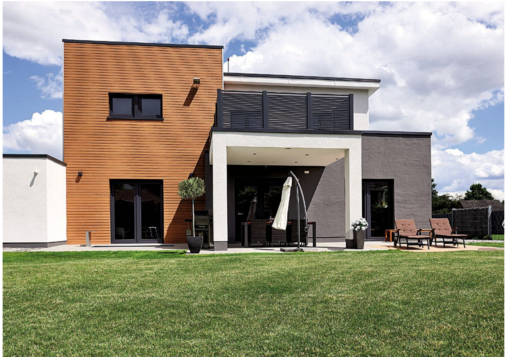
Fassadenprofile werden mit einer Nut- und Spundverbindung auf einer Holzunterkonstruktion angebracht. Foto: DJD/NATURinform
