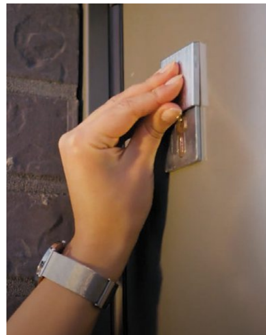
Bei Stromausfall lässt sich das Tor mit Schlüssel und einem Zug am Seil entriegeln.
