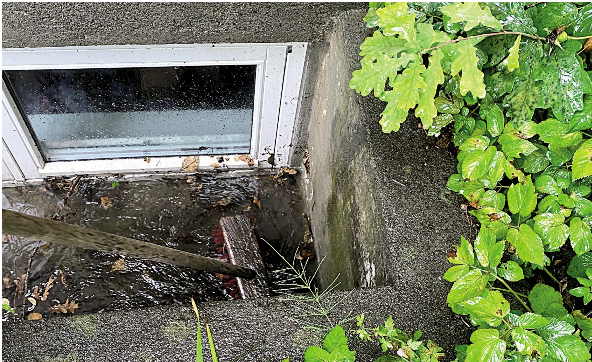
Wer rechtzeitig die Anschlüsse der Kellerfenster abdichtet, minimiert bei Hochwasser das Risiko von Wasserschäden im Gebäude. Foto: Scharvik/istockphoto.com/Triflex/akz-o
