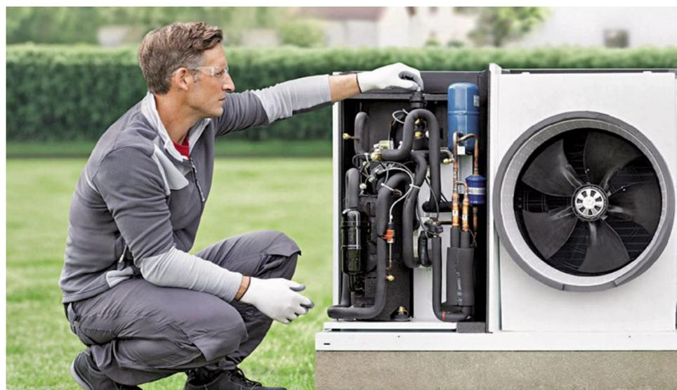
Bei Luft-Wasser-Wärmepumpen nutzt die Außeneinheit die Energie aus der Umgebungsluft, um das Zuhause behaglich zu heizen. Foto: DJD/Stiebel Eltron
