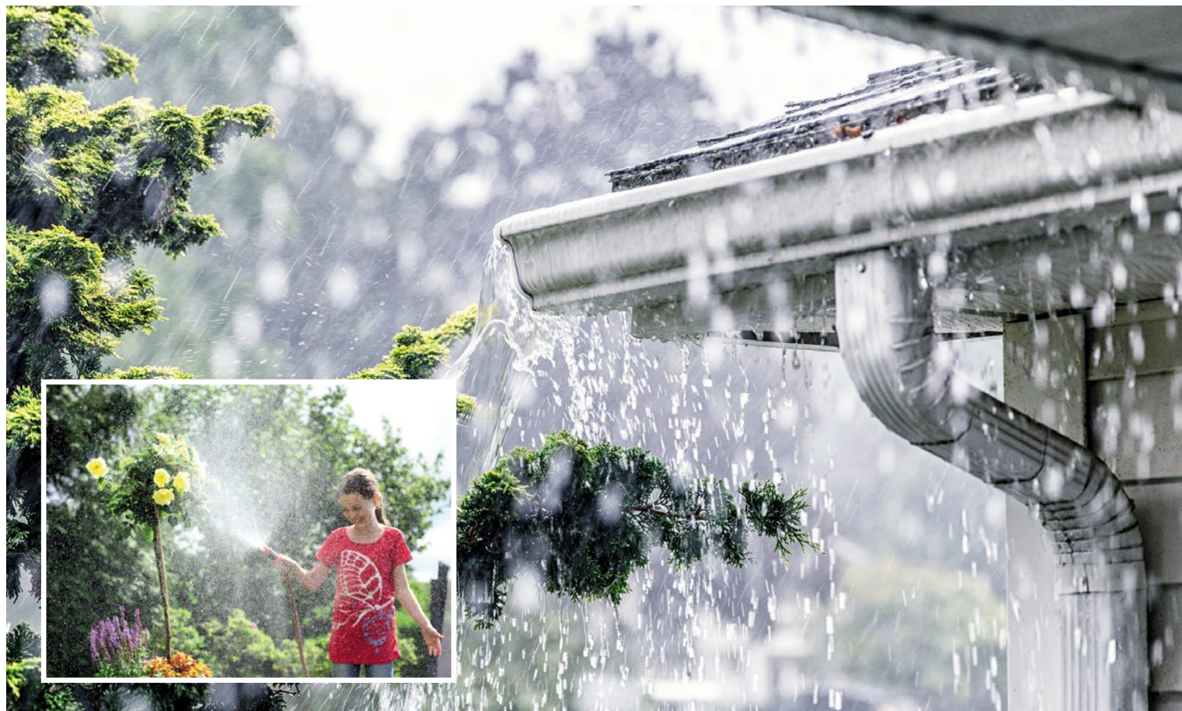
Über eine Dachfläche von 100 m 2 lassen sich bis zu 80 m 3 Wasser im Jahr auffangen. Foto: Willowpix/iStock.com/Intewa/akz-o
