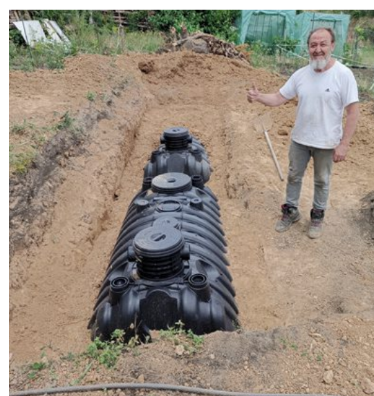
Dank geringem Gewicht und flachem Aufbau kann ein Erdspeicher ganz ohne schweres Gerät problemlos selbst eingebaut werden. Foto: Intewa/akz-o
