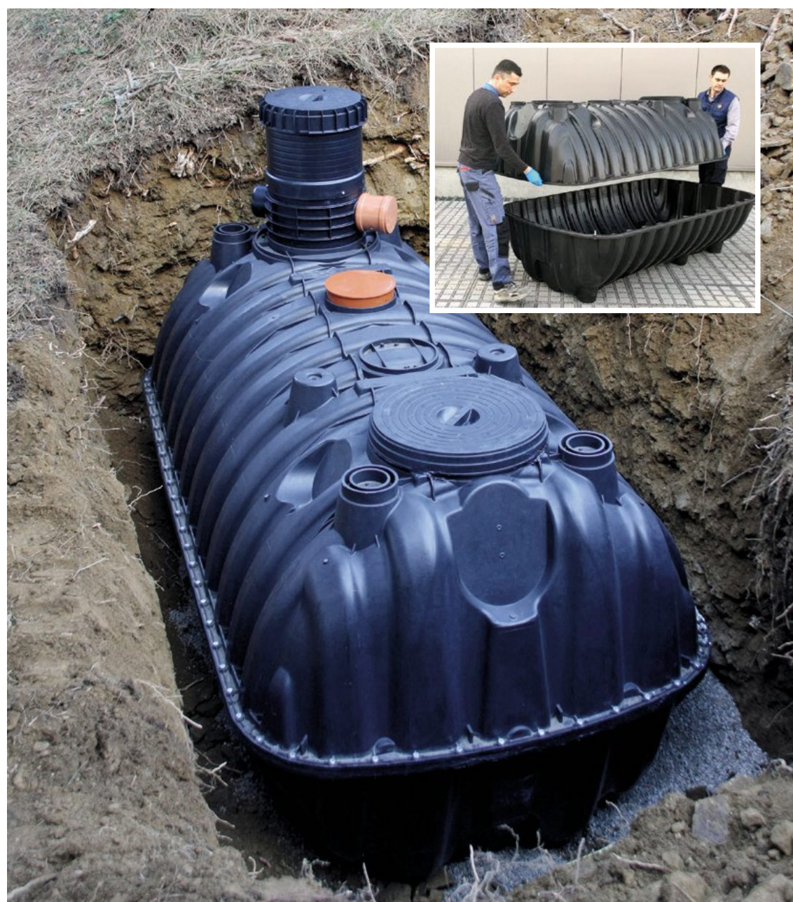
Dank geringem Gewicht und flachem Aufbau kann so ein Erdspeicher mit ein wenig Geschick und ganz ohne schweres Gerät selbst eingebaut werden. Foto: Intewa/akz-o
