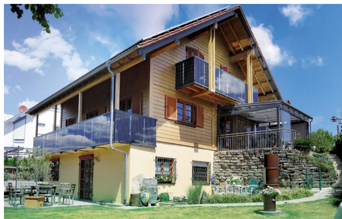
Eine Verkleidung aus Photovoltaikelementen gewinnt umweltfreundliche Energie, die bares Geld spart und dazu noch das Klima schützt. Foto: DJD/www.solarcarporte.de
