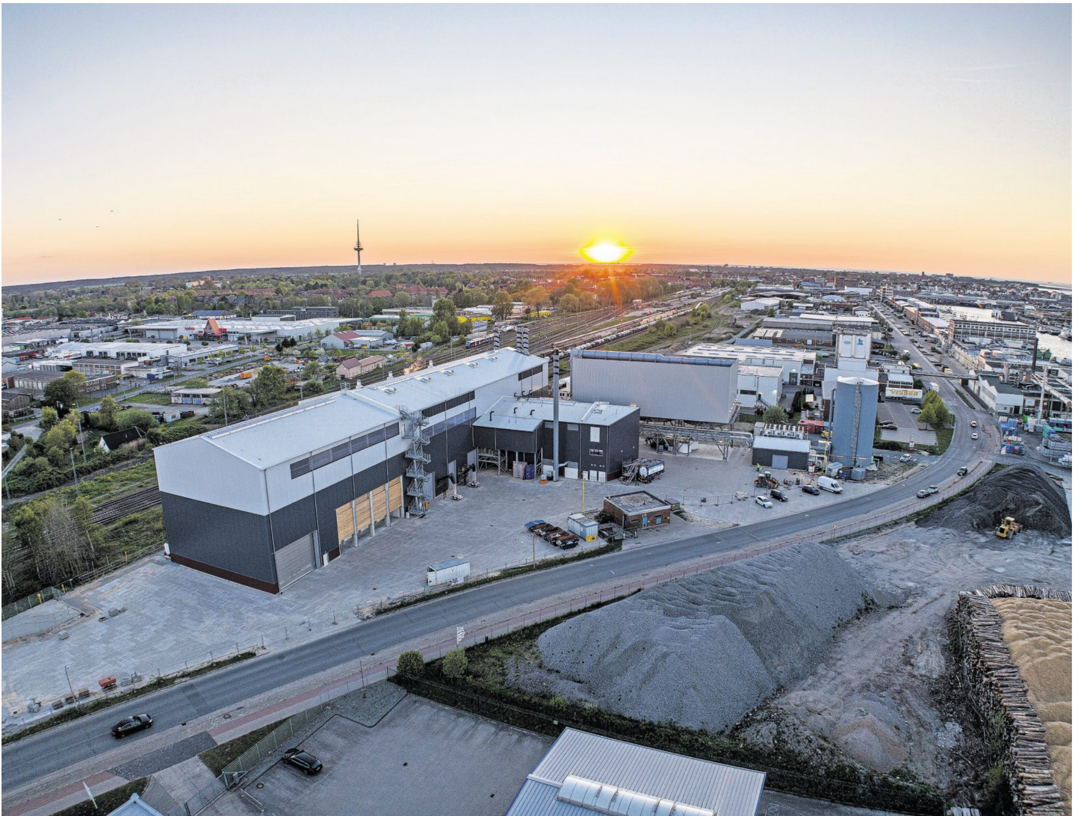
Das Kraftwerk, das in den vergangenen Jahren an der Neufelder Straße entstanden ist, soll im Herbst diesen Jahres ans Netz gehen. Foto: Forte Energie GmbH
