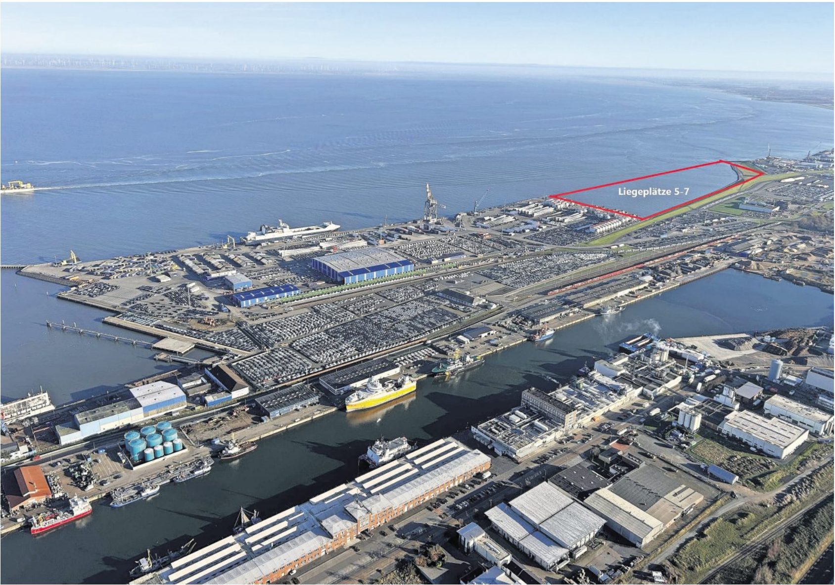
Der Cuxhavener Hafen aus der Vogelperspektive. Im Vordergrund der Neue Fischereihafen, dahinter die Flächen von CuxPort, rechts oben ist der Umriss der im Bau befindlichen Liegeplätze 5 bis 7 rot eingezeichnet. Foto: Makel
