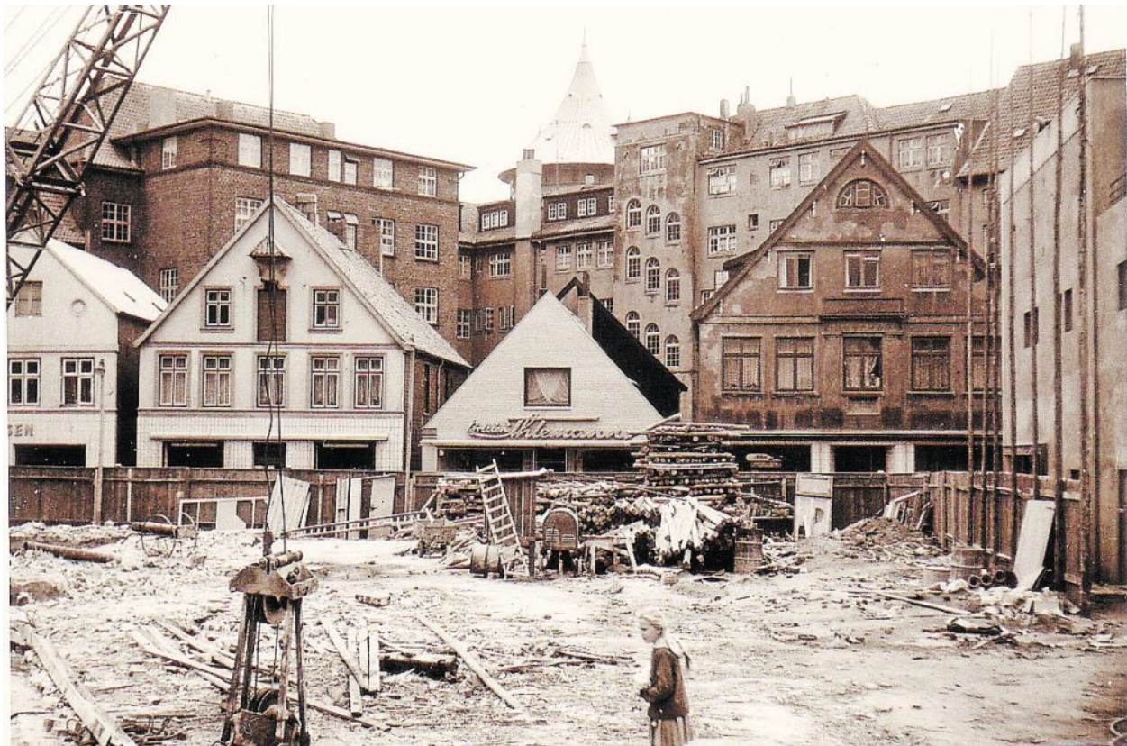
Blick über die Baustelle: Die Bauarbeiten für das neue Karstadt-Haus im September 1959 im nördlichen Teil der Nordersteinstraße.
