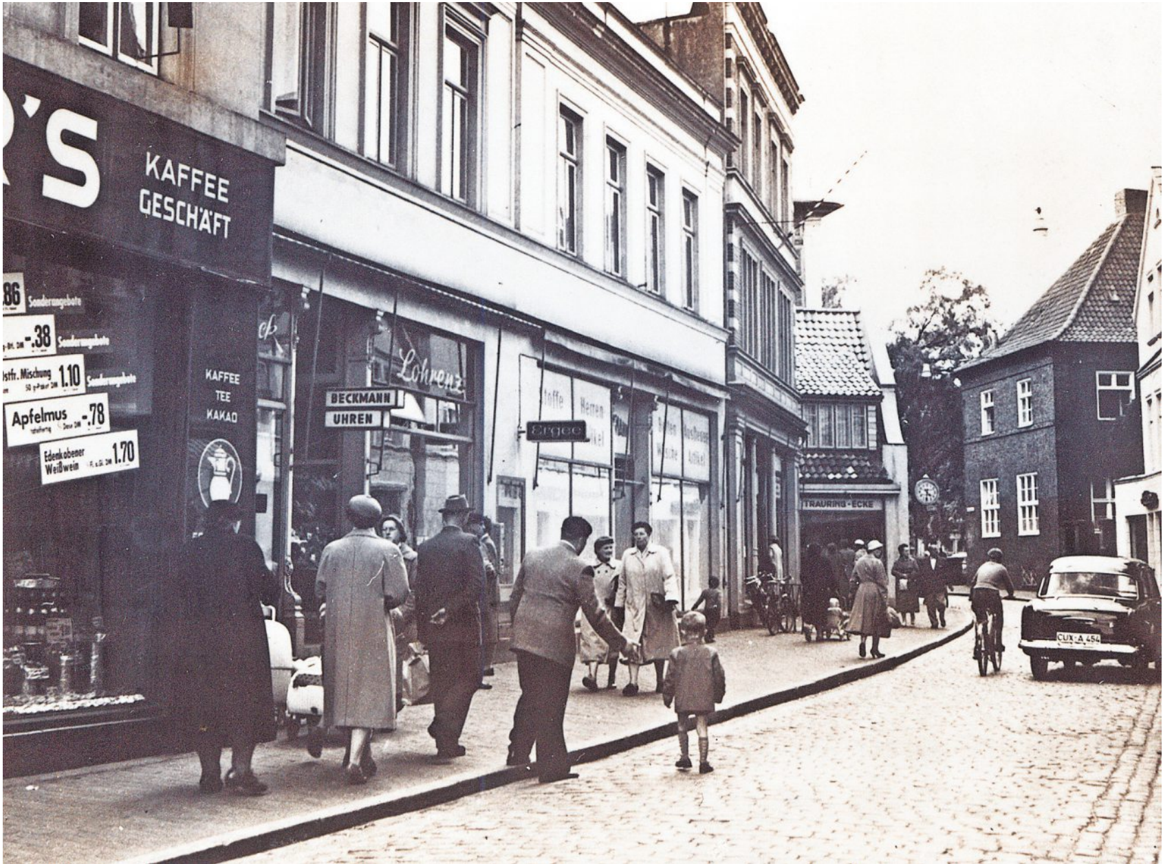
Begegnungsverkehr war hier zu dieser Zeit in den 1950-er Jahren in der Nordersteinstraße schon unmöglich.
