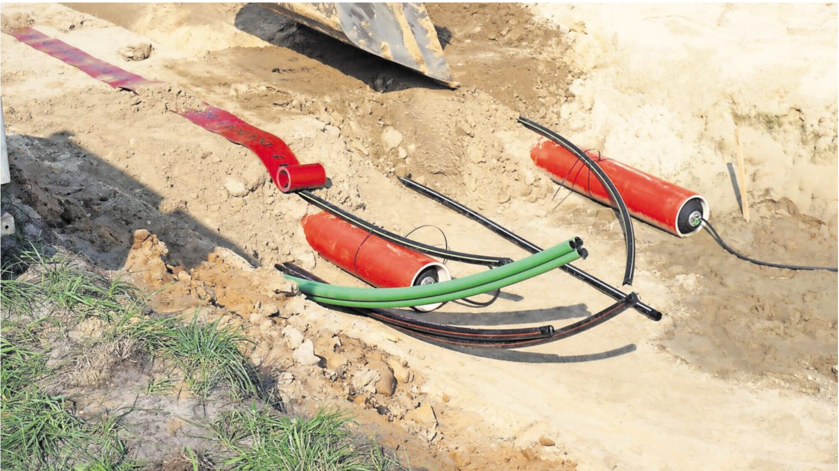
Kabelgraben: Der Übertragungsnetzbetreiber TenneT hat die Tiefbauarbeiten für die SuedLink-Erdkabeltrasse im Abschnitt zwischen Wischhafen und Kutenholz vergeben. Die trasse streift auch den Landkreis Cuxhaven. Foto: TenneT
