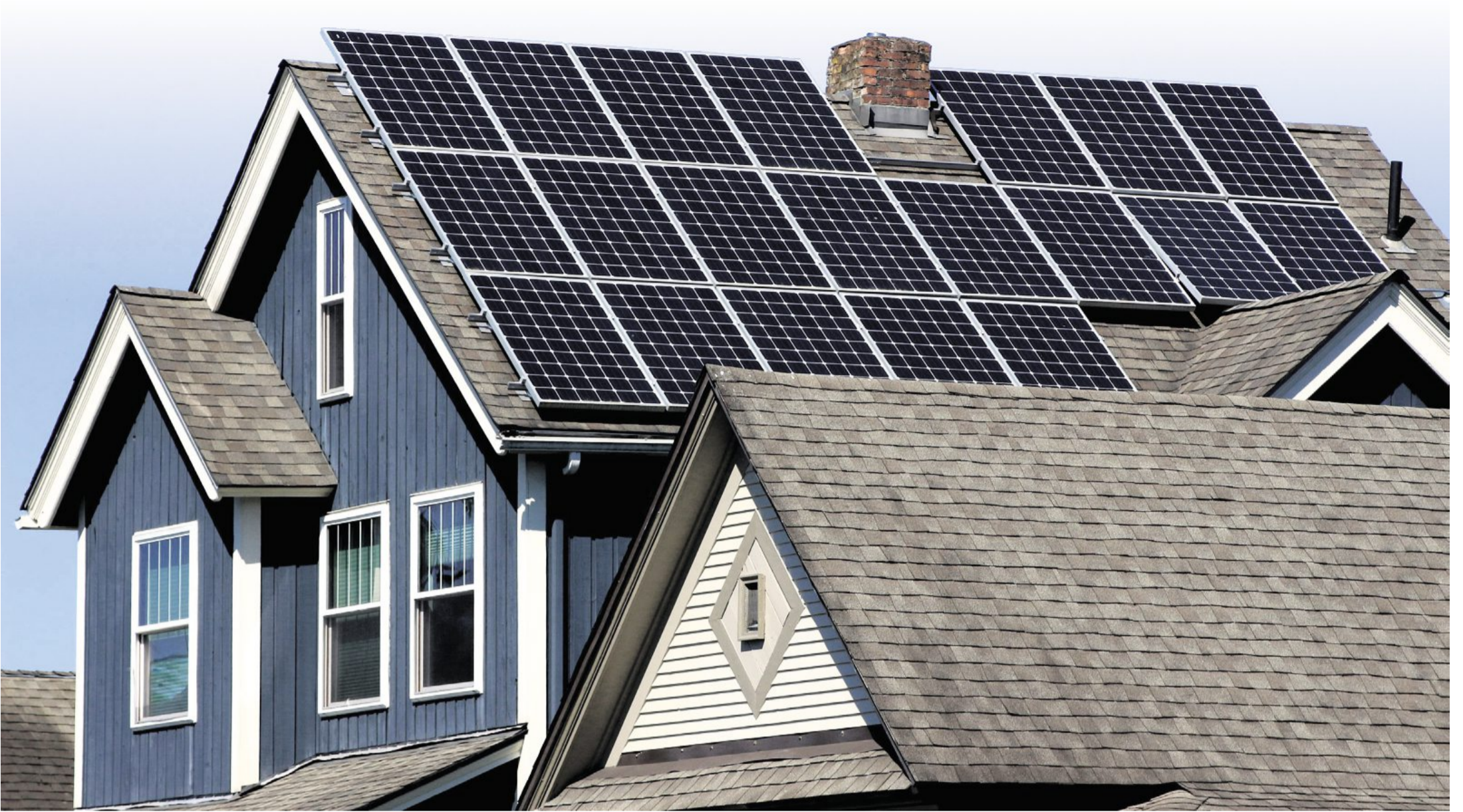
Bei Heizung und Warmwasser setzen immer mehr Menschen auf Solarenergie.
